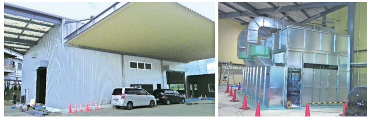
アコオ機工、新塗装棟外観（写真左）と小物塗装ブース
